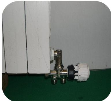
Válvula bitubo termostatizable o manual para radiadores de diseño tipo Runtal, toalleros, aluminio y fundición.
