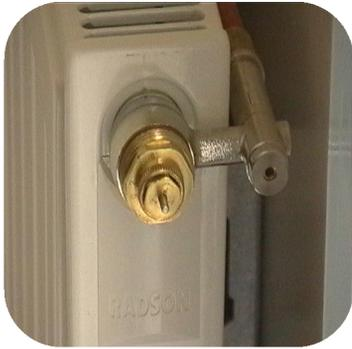
Válvula bitubo manual o termostatizable para radiadores de acero tipo panel; fácil y rápido montaje.
